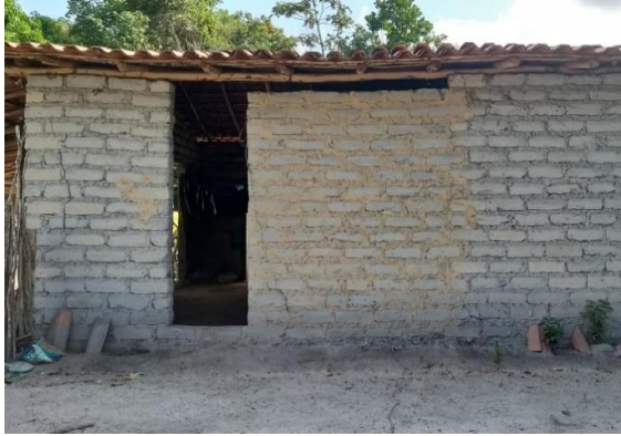
Fig. 04: Residência em adobe queimado ao sol sem uso de pilares ou vigas.
